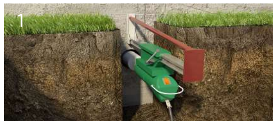
Алмазное сверление фундамента для прокладки канализационного трубопровода.
